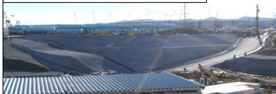
【写真②】法面モルタル吹付施工状況
