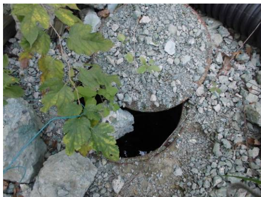
No. 47ピットの状況 (H26.10時点)
