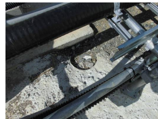
No. 49ピットの状況 (H26.10時点)
