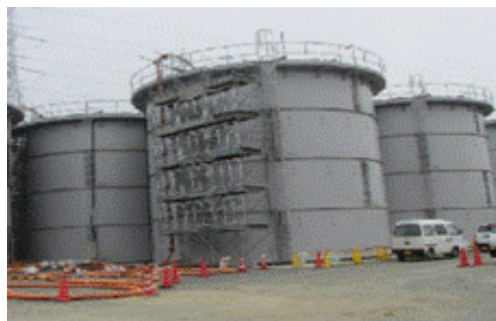
フランジ型タンク
