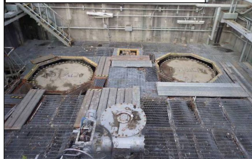
逆洗弁ピット(2号)内瓦礫撤去完了
