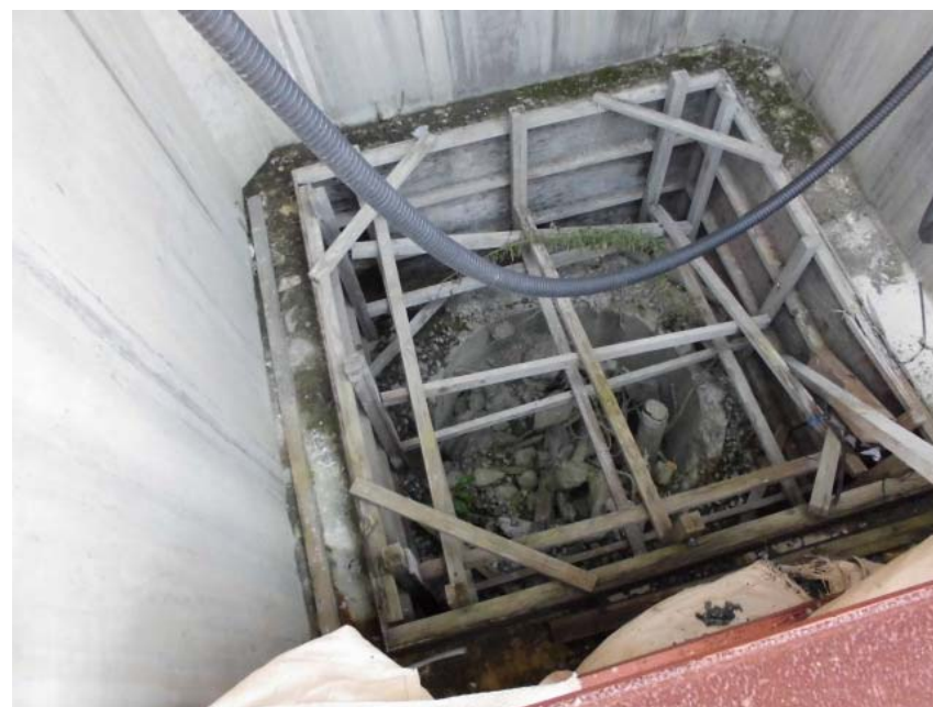
No. 39ピットの状況 (H26. 10時点)
