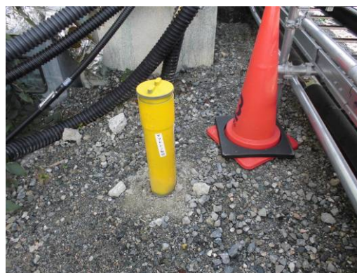
No. 48ピットの状況 (H26.10時点)
