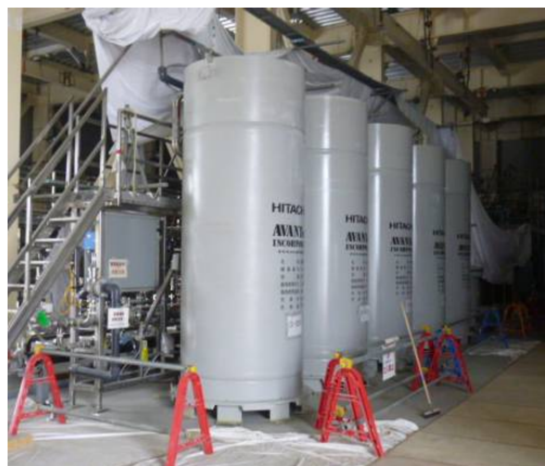
浄化設備（吸着塔）
