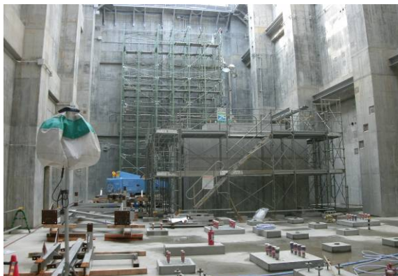
焼却設備室 自動倉庫設置作業中（奥側）。 今後主要機器の据え付けを行う。
