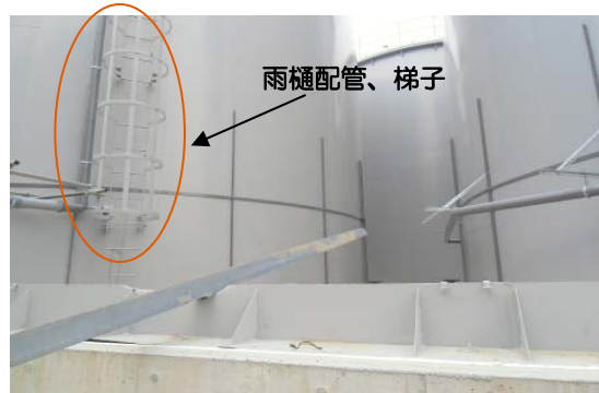
J1エリアタンク、雨樋配管、梯子について目視点検 を行い異常なし。
