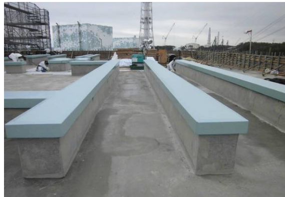
屋上東側 防水工事作業中。
