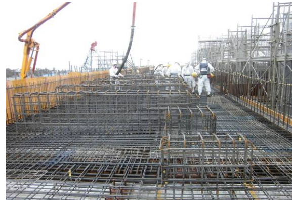
屋上北側 躯体工事（配筋、型枠、コンクリート工事）作業中。
