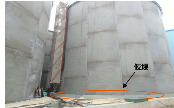
A-3、A-4の仮堰について目視点検を行い異常なし。
