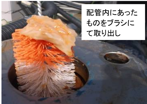
流量計下部の配管 (流量計取り外し)
