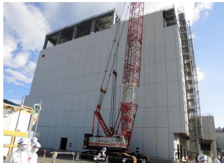
【現状】外壁工事实施中
