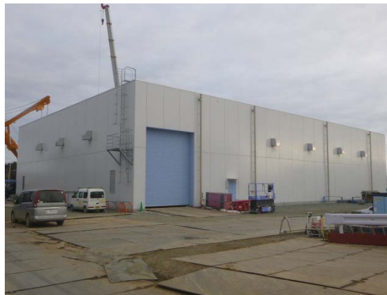
サブドレン浄化設備建屋全景
