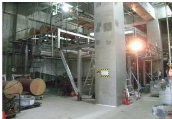
排ガスフィルタ及び煙道 排ガスフィルタの設置及び煙道の布設作業中。
