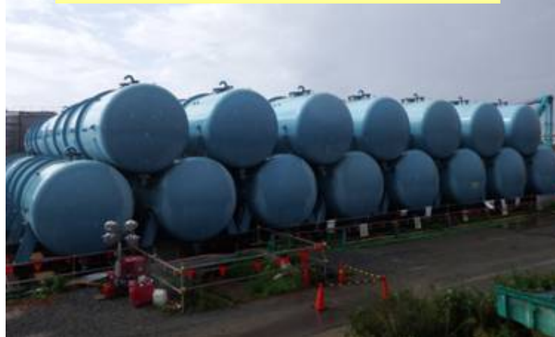
Gエリア 撤去タンク保管状況
