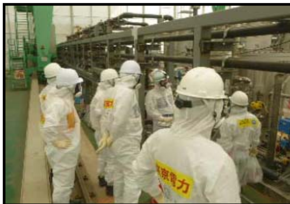
現場作業員への指導状況 (高性能ALPS設置作業)
