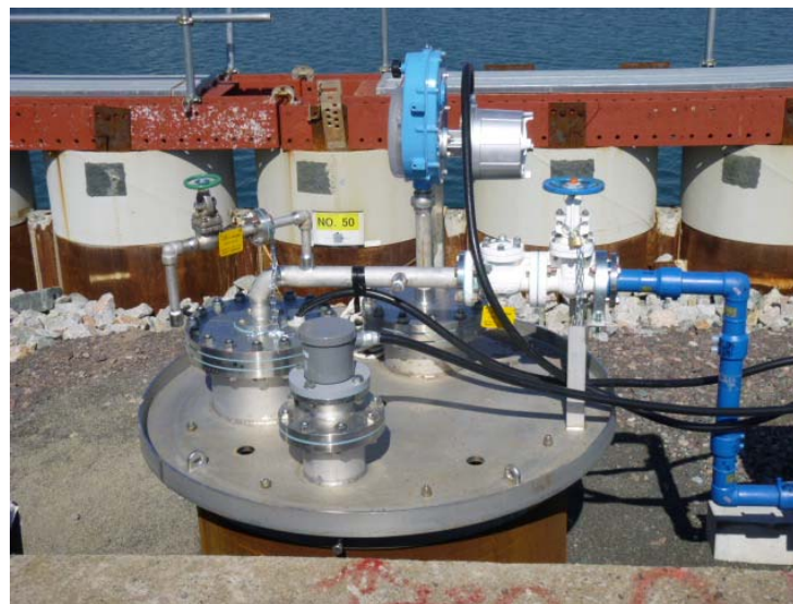
地下水ドレンポンド（A）
