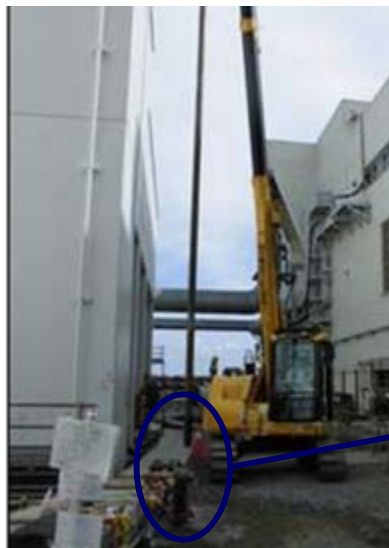
二重管（内ケーシング）設置
