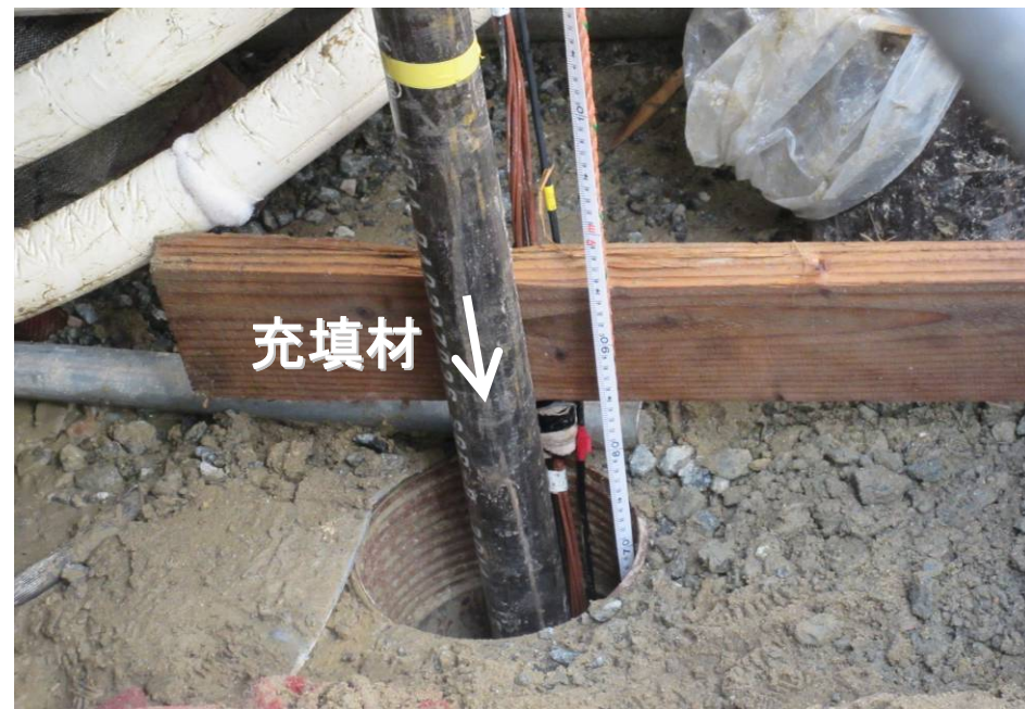
充填孔 (K 1 孔) 付近の様子
