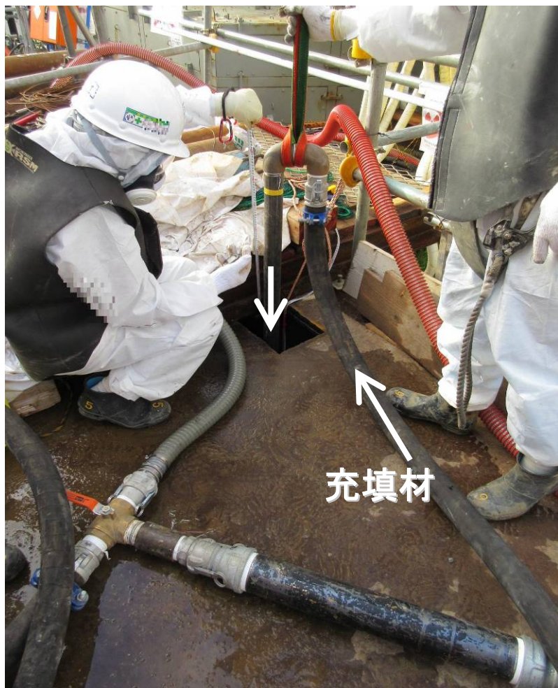
間詰め充填作業の様子
