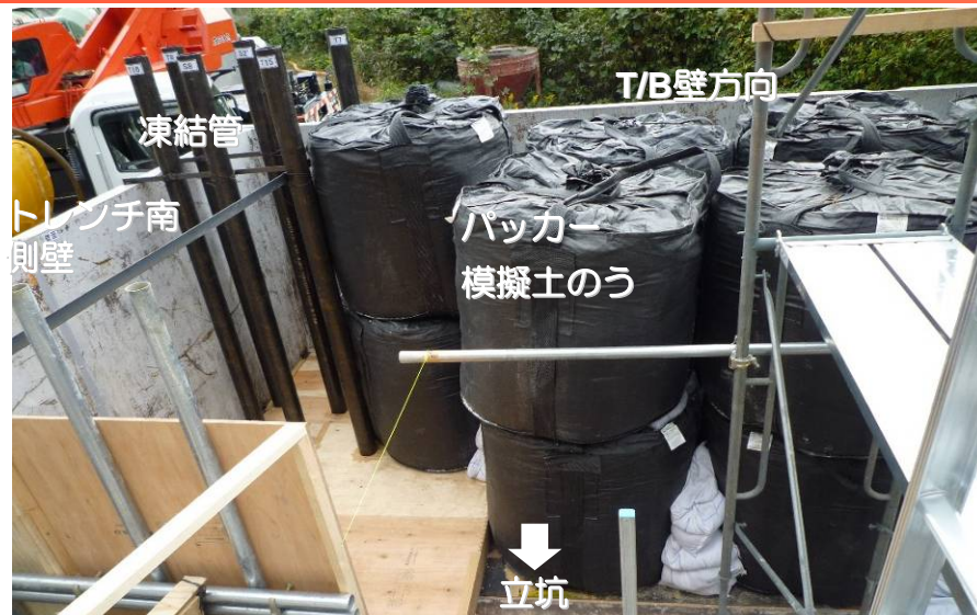
試験前 設備配置状況
