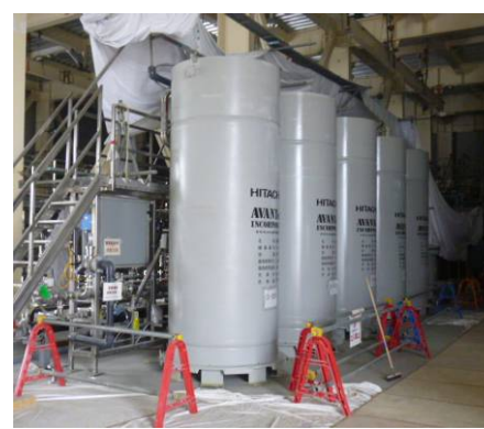
浄化設備 (吸着塔)
