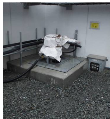
サブドレンピット
