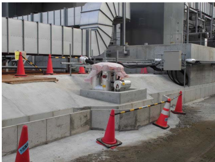
N15サブドレンピット
