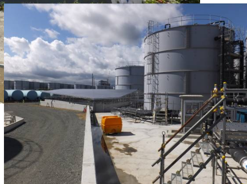
②H3エリア 堰カバー設置完了 (右下 内堰拡張部)
