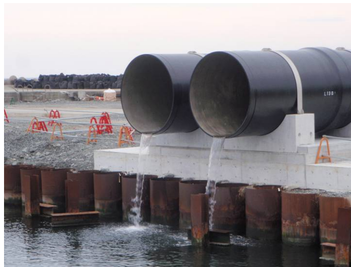
本設の排水口
