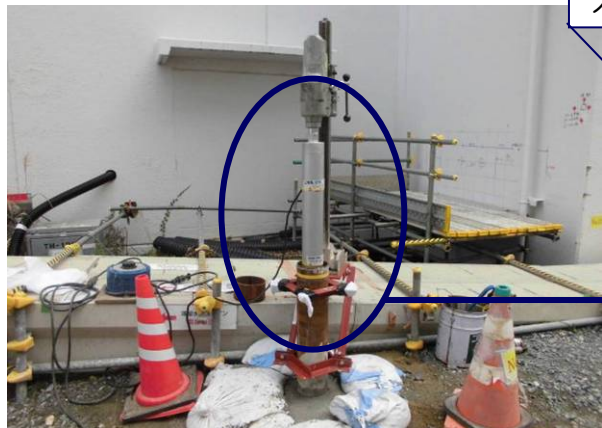
削孔（コア抜き）
