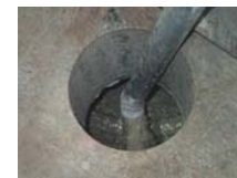
グラウト充填部完了 (閉止板設置) グラウト充填 施工状況
