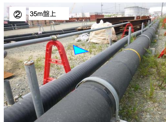
新規ルートPE管の敷設状況（代表例）
