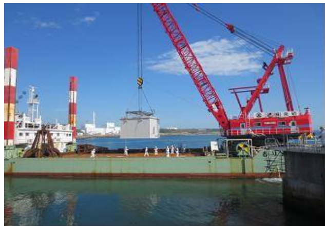
サンプリングラックカバー設置状況
