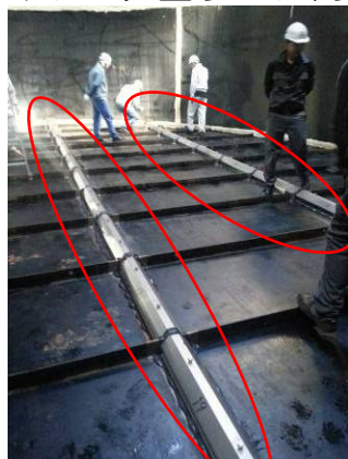
フランジ面2ラインに施工
