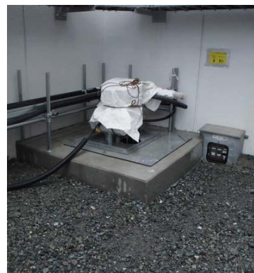
サブドレンピット
