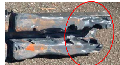
1カ所充填材の欠損確認 シール材の盛りつけ不十分が原因
