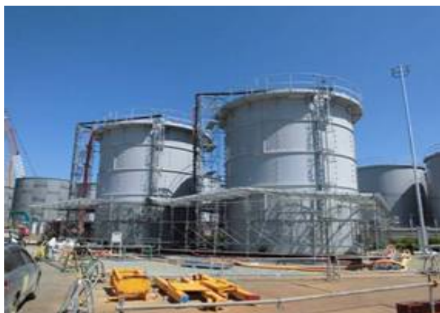
淡水化处理RO膜装置サンプルタンク (完了)
