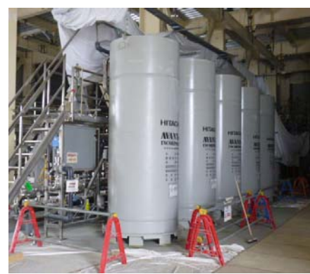
浄化設備 (吸着塔)
