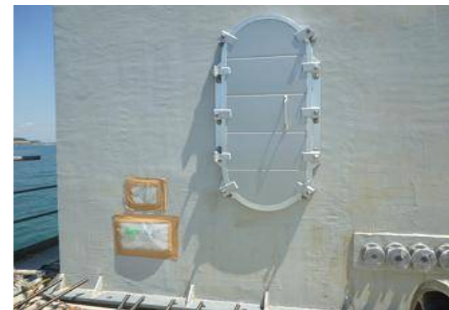
カバー出入口扉
