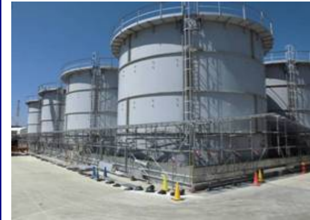
4000t鋼製角型タンク群(完了)
