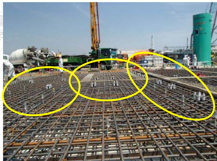
写真②：冷凍機アンカー設置状況
