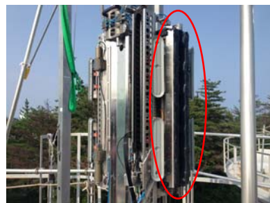
カバープレートをマストに取り付け
