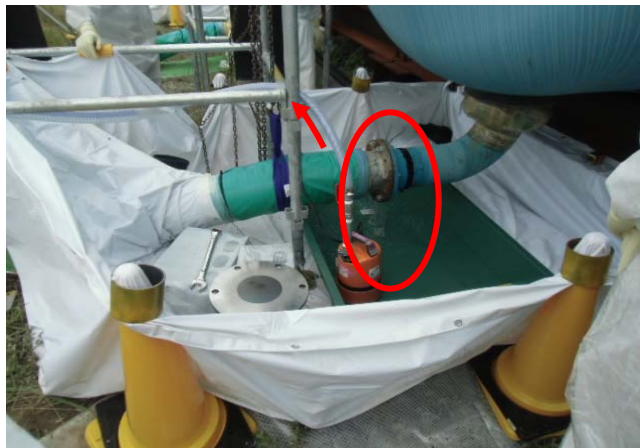
図：残水抜き状況
