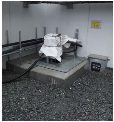
サブドレンピット
