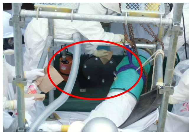
図：閉止板取り付け
