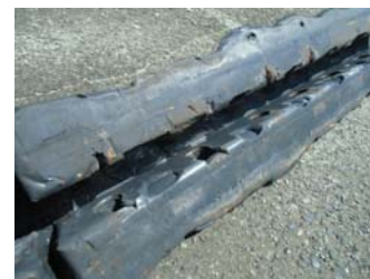
カバープレートをバールで剥がして確認。十分押付けられ底板と密着を確認。
