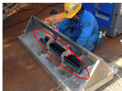
塗布したカバープレートを吊上げ用のボックスに格納
