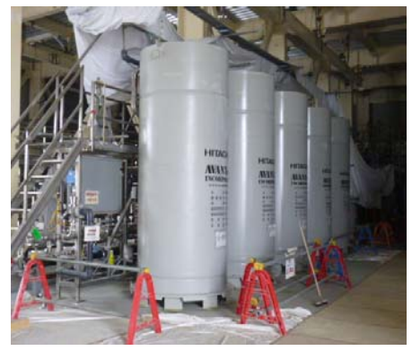
浄化設備 (吸着塔)
