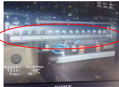
底板フランジに取り付け（水中カメラにて撮影）
