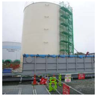
一時貯留タンク
