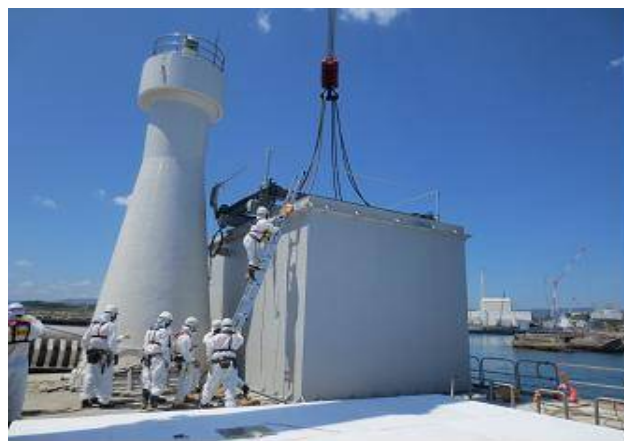
サンプリングラックカバー設置状況
