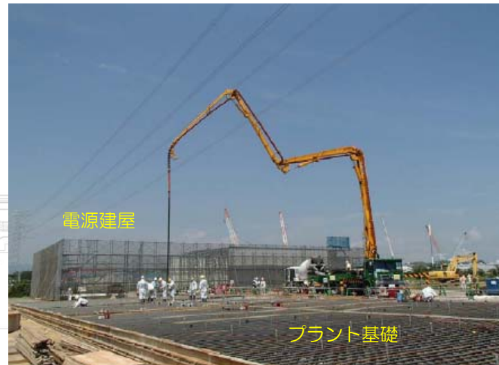
写真①：プラント基礎コンクリート打設状況
