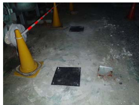
グラウト充填部完了 (閉止板設置) グラウト充填 施工状況
