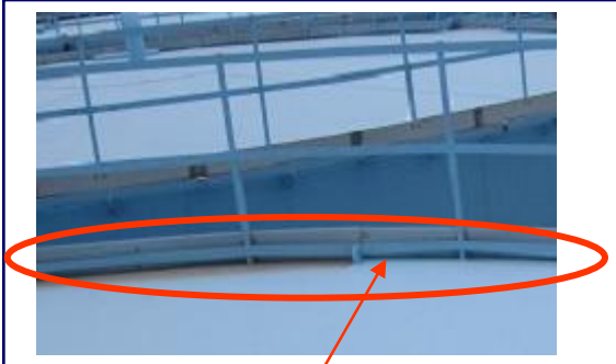
①金属製雨樋（止水板）
