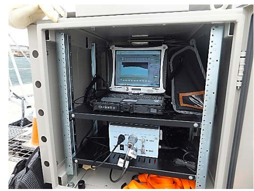
キャビネット内部の計測機器
