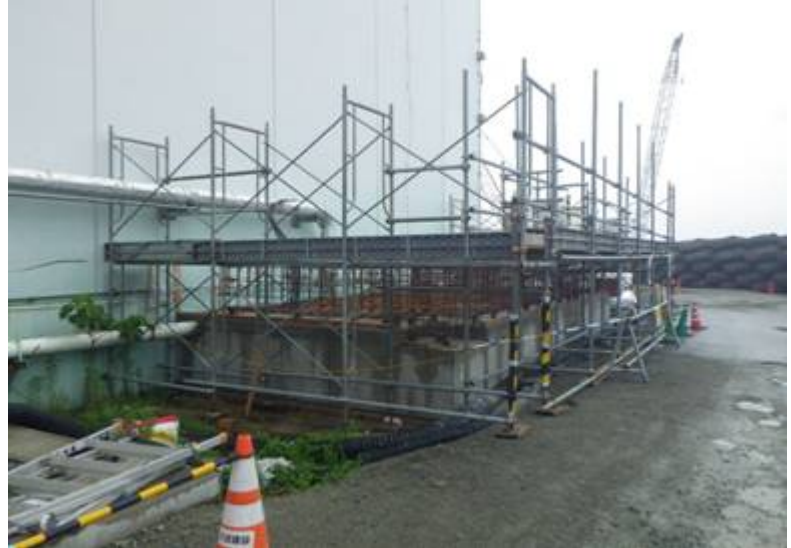
No5中継タンク基礎工事状況
