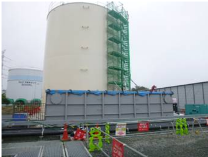
サンプルタンク設置状況
