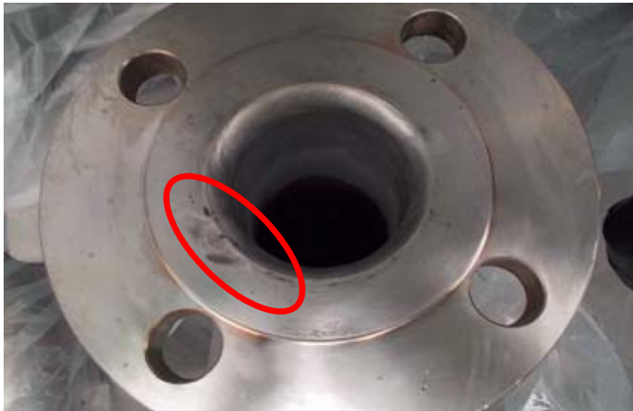
②吸着塔2C出口弁フランジ（上流 弁側）の腐食の様子
