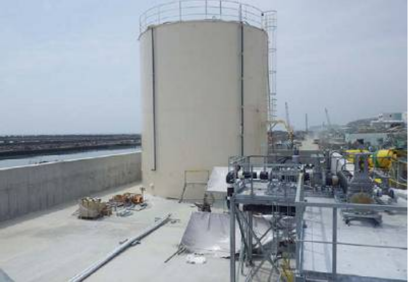
集水タンク設置状況
