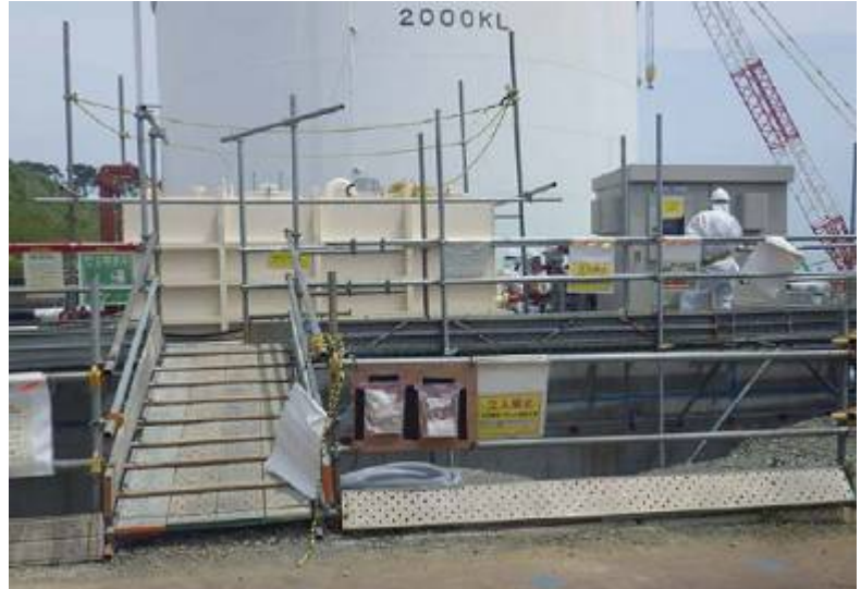
No2中継タンク設置状況
