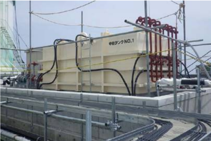
No1中継タンク設置状況
