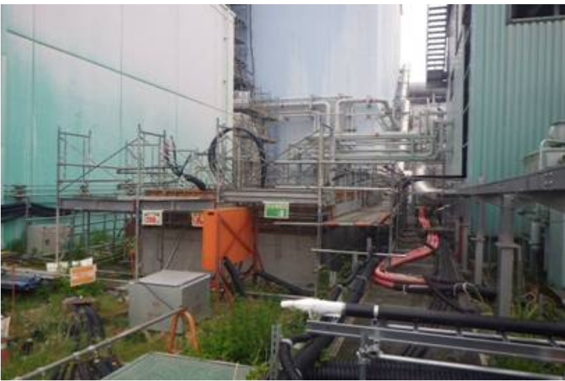
No3中継タンク基礎工事状況
