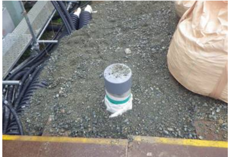
新設サブドレンピットN12
