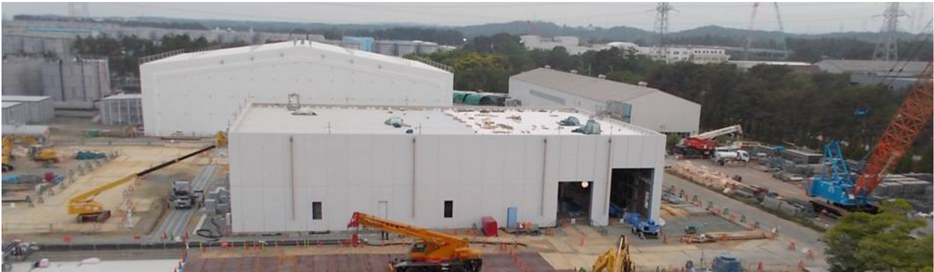
工事エリア全景（北面）
