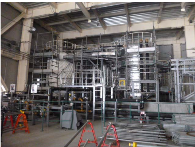
処理装置供給タンク据付状況
