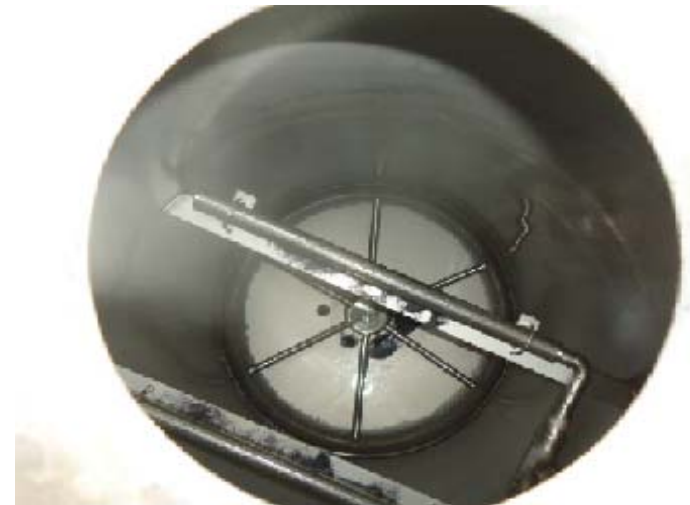
(参考) 吸着塔2C内部の様子 (腐食なし)
