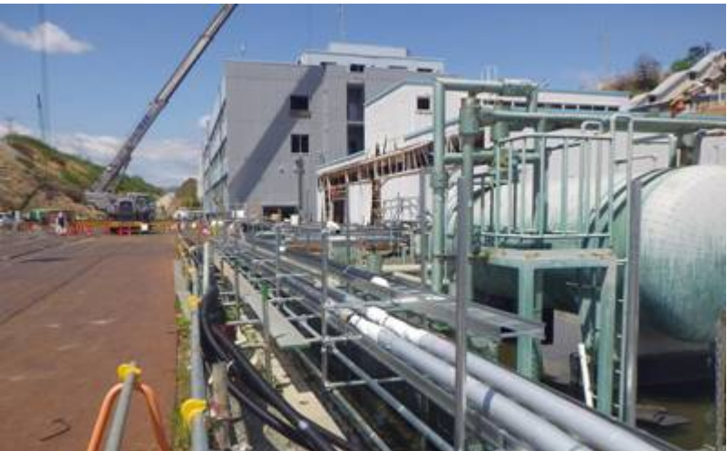
移送配管敷設状況（1号機北側）
