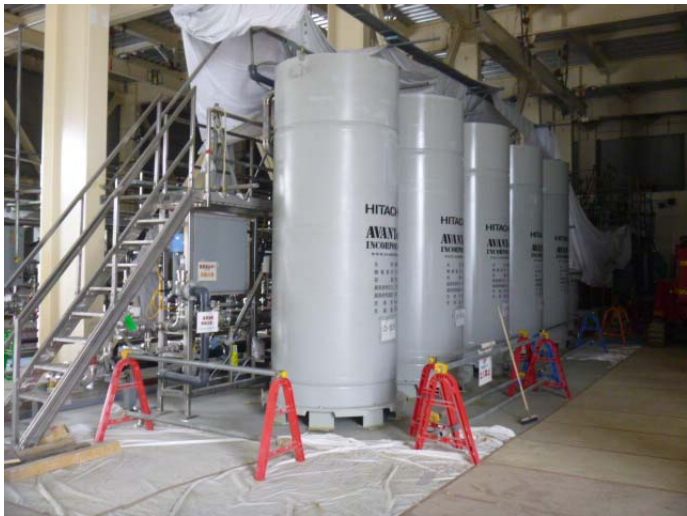
吸着塔据付状況
