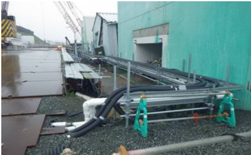
移送配管敷設状況（1号機東側）
