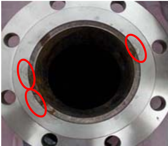
①吸着塔2C点検口フランジ部の腐食の様子
