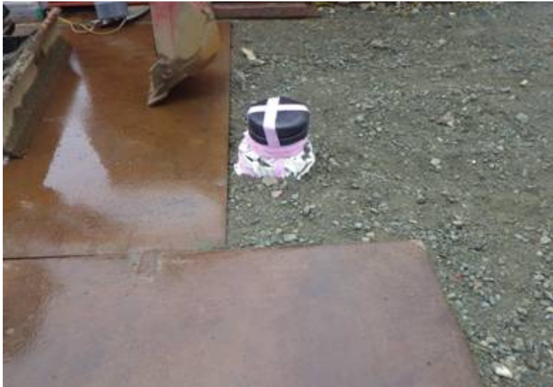
新設サブドレンピットN14
