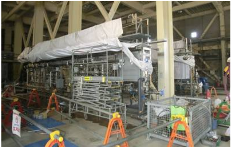
前処理スキッド設置状況
