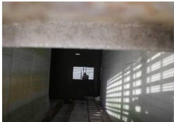
② 1号機下流側立坑
