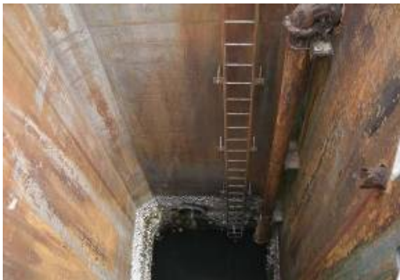
① 1号機上流側立坑
