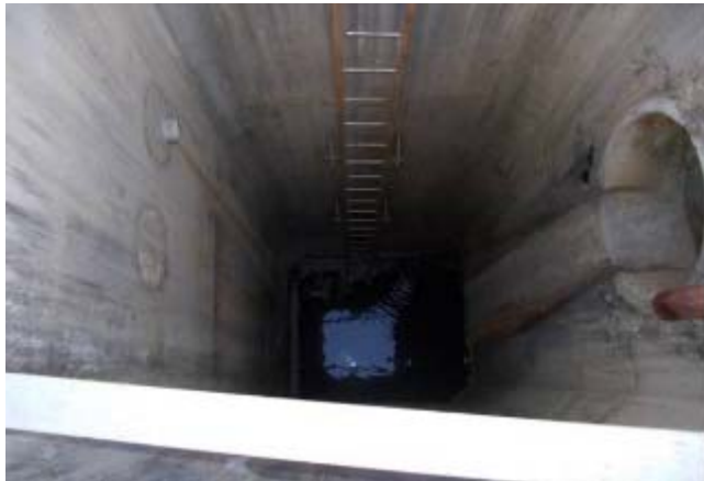
①' 2号機上流側立坑
