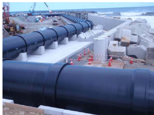
写真D ライン③基礎状況
