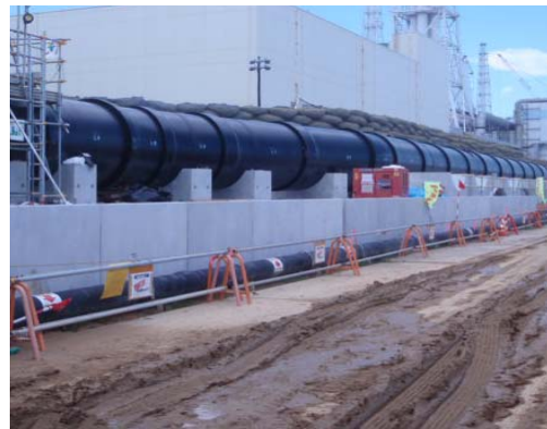
写真C ライン②排水管据付状況
