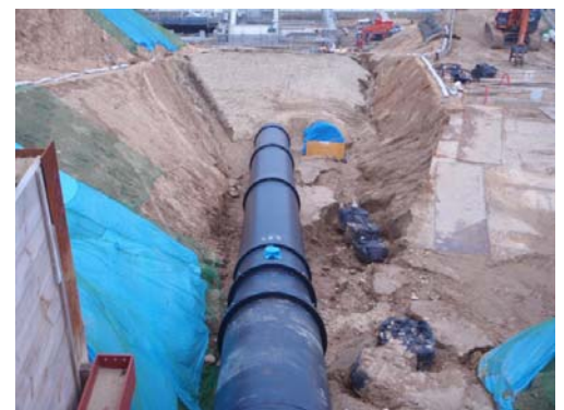
写真A ライン①排水管据付状況
