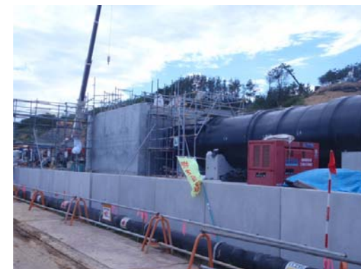
写真A ライン①排水管据付状況
