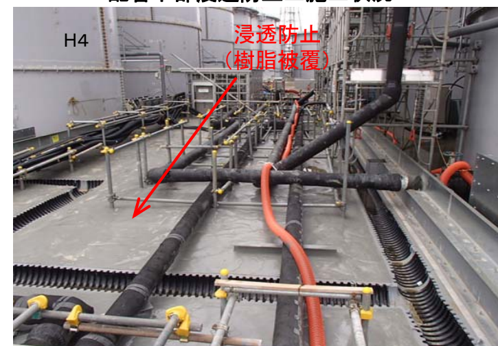
配管下部浸透防止工施工状況
