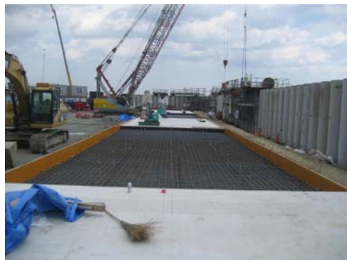
写真④ ライン③基礎状況
