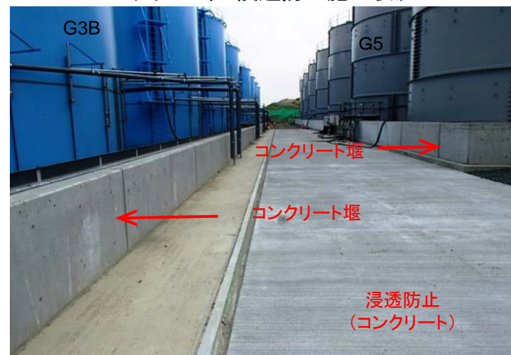
コンクリート堰・浸透防止施工状況
