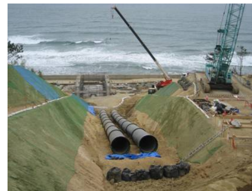
写真① ライン①排水管据付状況
