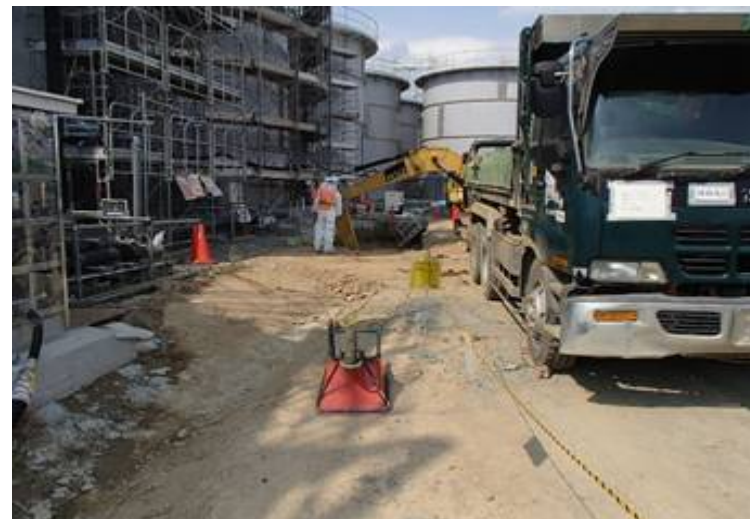
汚染土の掘削(H6エリア)
