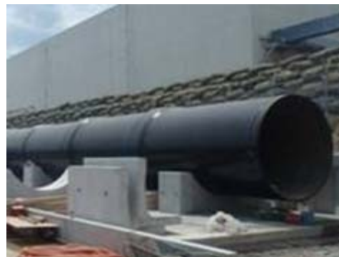
写真③ ライン②排水管据付状況
