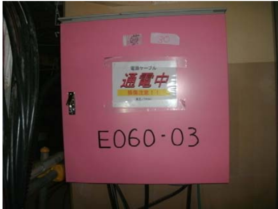
仮設分電盤N-1 (プロセス主建屋2階)
