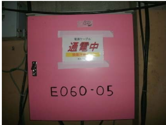
仮設分電盤N-3 (焼却・工作建屋1階)
