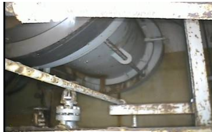
主蒸気配管C
