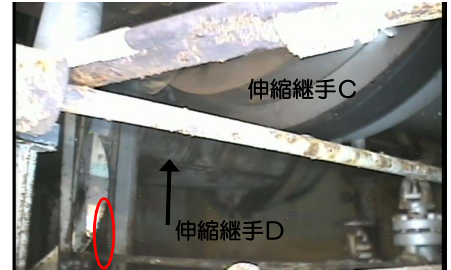
主蒸気配管D
