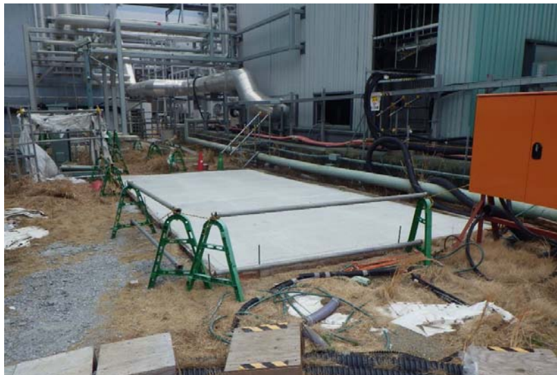
中継タンク③均しコンクリート打設状況
