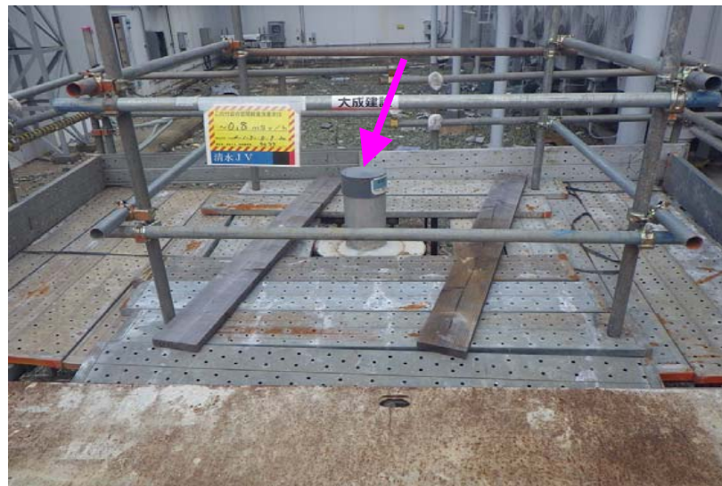
新設サブドレンピットN4（掘削完了）
