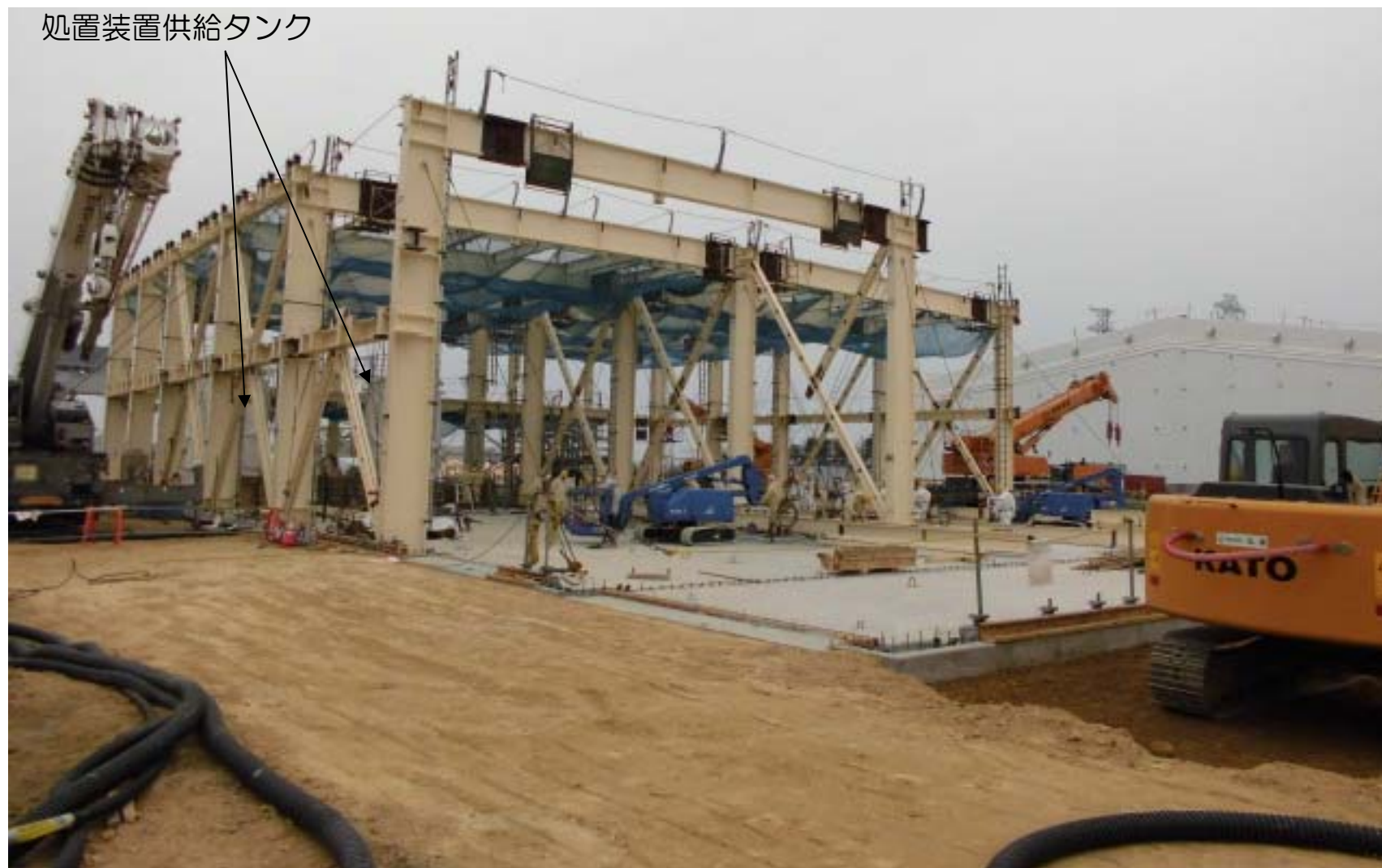
鉄骨建方状況
