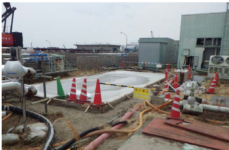
中継タンク①均しコンクリート打設状況
