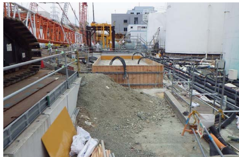
中継タンク②均しコンクリート打設状況
