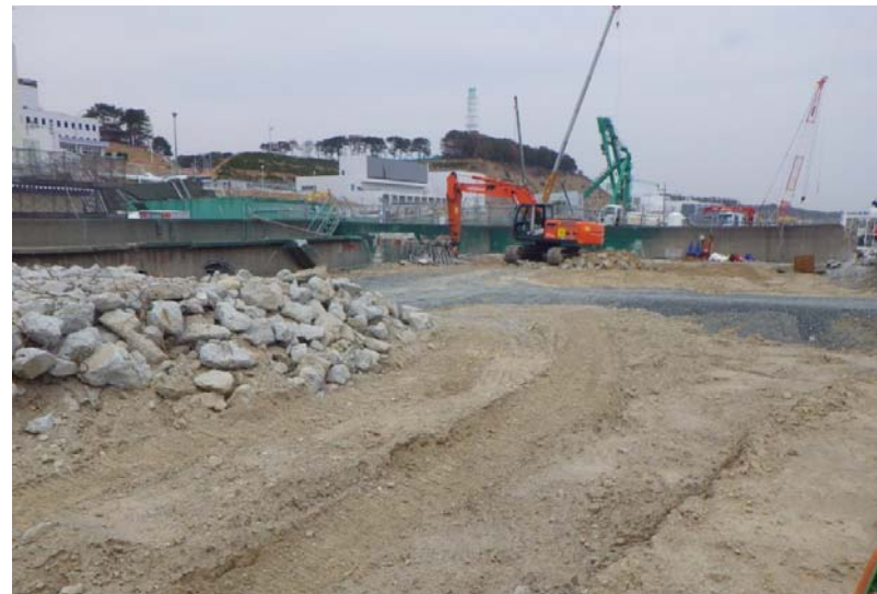
集水タンクエリア敷地造成状況
