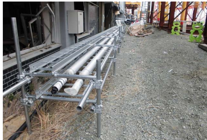
水移送配管敷設状況
