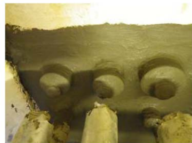
<止水処理後の配管貫通部(ダクト側)> 平成24年12月19日 協力企業作業員撮影
