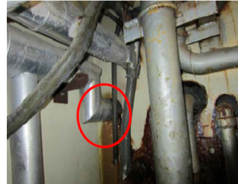
<水流入箇所の配管貫通部(建屋側)> 平成24年5月29日 当社社員撮影
