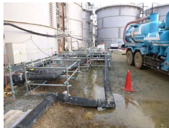
漏えいの状況 (①エリア)
