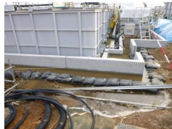
漏えいの状況 (③エリア)
