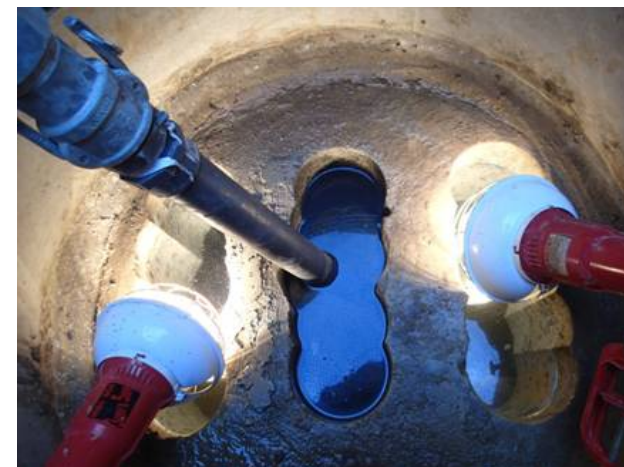
グラウト注入プラント (H26.2.7撮影)
