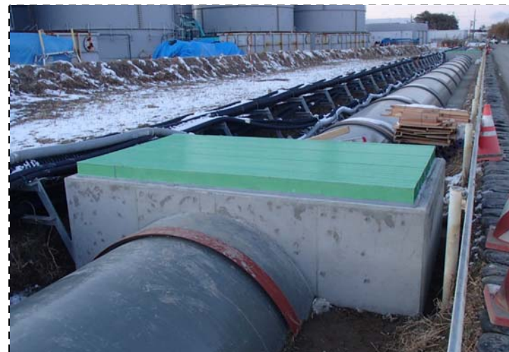
③暗渠化（FRP管・柵）施工完了（H26.2.7）
