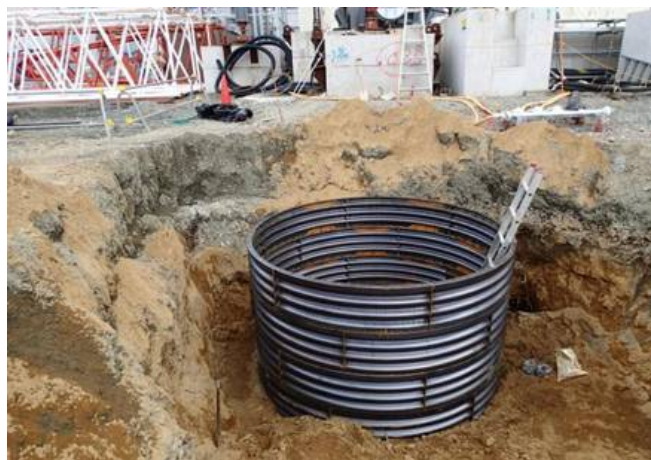
立抗掘削状況 (H26.1.9撮影)
