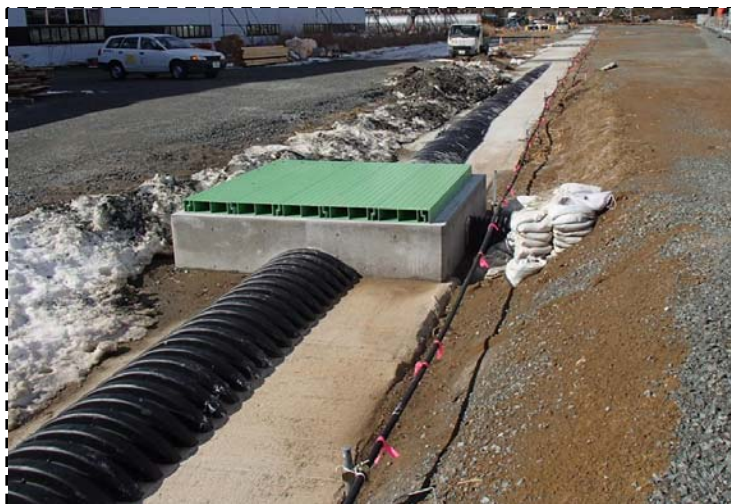
①暗渠化（プラスチック管・柵）施工完了（H26.1.15）
