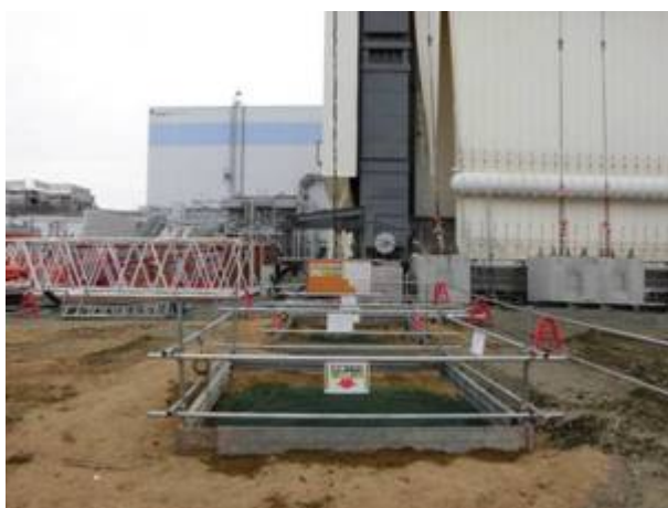
安全設備設置完了 (H26.1.15撮影)
