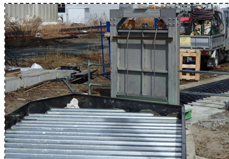
④止水ゲート施工状況（H26.2.16）
