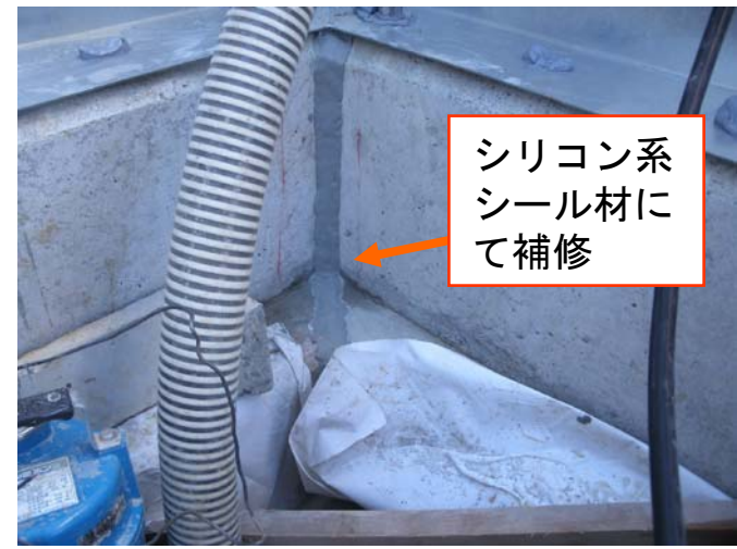
【G6北 北東角部の漏水箇所の補修状況】
