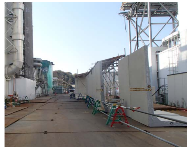
② 2号開削ダクト現況
