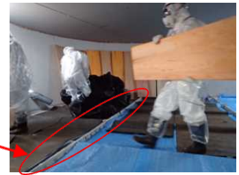
<4-10. 作業方法及び現場の状況場所>
