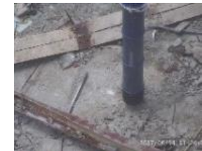
<1-13. 吸引装置による小瓦礫撤去の様子 (オペレーティングフロア調査時)>
