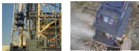
(2017年1月撮影) <1-11 飛散防止剤散布状況>
