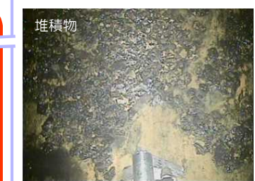
<4-6. 制御棒駆動機構交換用レール上の堆積物>
