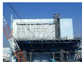
<4-2. 構台・前室設置状況>
