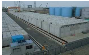
使用済吸着塔類のコンクリート製の一時的保管施設への収納
