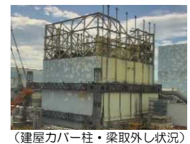
(建屋カバー柱・梁取外し状況)
