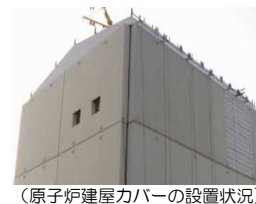
(原子炉建屋カバーの設置状況)
