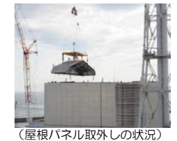
⑦ 1号機原子炉建屋カバー解体の状況
