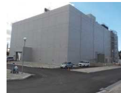
③-1 雑固体廃棄物焼却設備の外観(2016年3月より運用開始)
