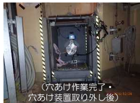
<3-5. 穴あけ作業状況>
