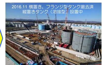
<5-3 横置きタンクの縦置きタンクへのリプレース (H2エリア)>
