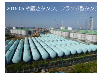
<5-3 横置きタンクの縦置きタンクへのリプレース (H2エリア)>
