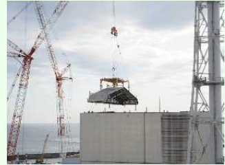
1号機建屋カバー屋根パネルの取り外し完了
