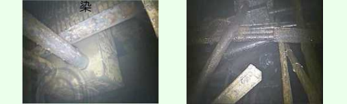
3号機格納容器内部映像の例（下部方向の映像）
