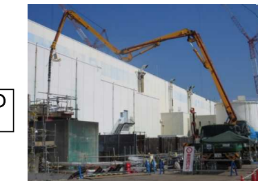
<トレンチ内部充填・閉塞の状況>
