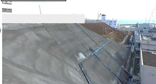
<35m盤 北側エリア：モルタル吹付施工状況>
