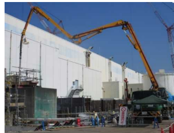
<トレンチ内部充填・閉塞の状況>
