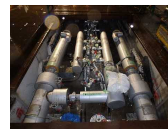
供給管接続後 8/27
