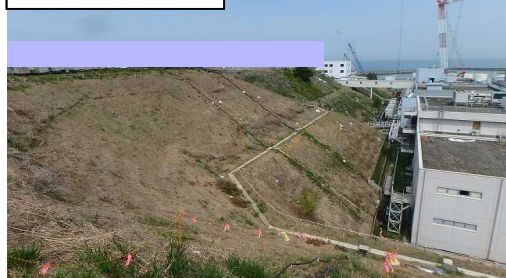
<35m盤 北側エリア：モルタル吹付施工状況>
