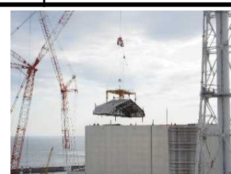
最後の屋根パネルの取り外し
