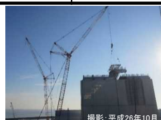
屋根パネルの取り外し
