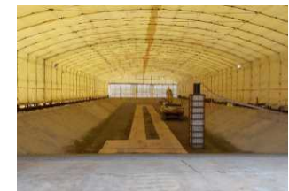
覆土式一時保管施設第3槽全景
