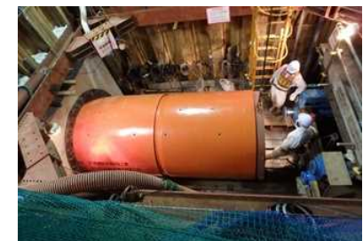
<写真② 推進機投入・接続>
