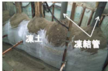
凍結管周囲の土が凍り始めます
