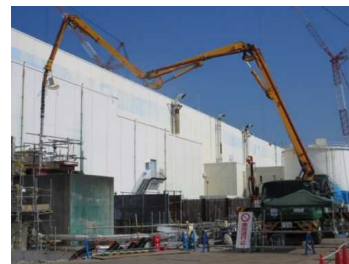
＜トレンチ内部充填・閉塞の状況＞
