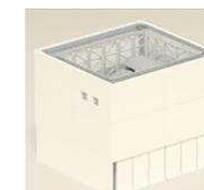
(注) オペレーティングフロア(オペフロ)：定期検査時に、原子炉の蓋を開放し、炉内燃料取替や炉内構造物の点検等を行う原子炉建屋最上階のフロア。
