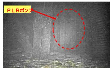
原子炉再循環ポンプ（PLRポンプ）や格納容器内壁面にも大きな損傷がないことを確認しました。
