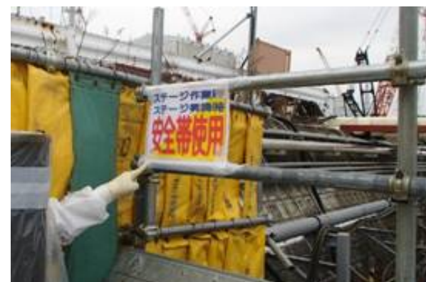
是正後（安全帯使用の標識を設置）
