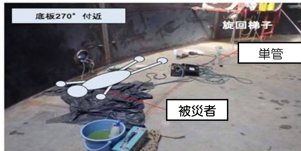
H26.9.20 単管パイプが落下し負傷
