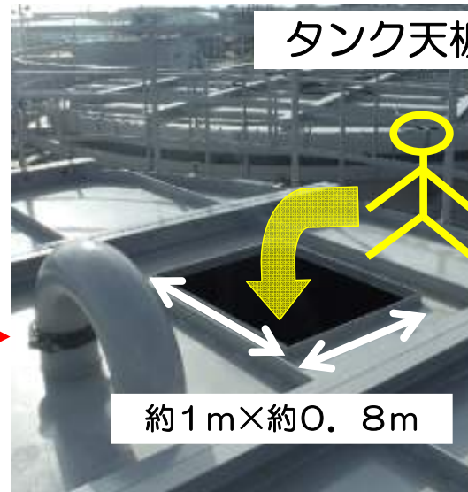
タンク天板部
