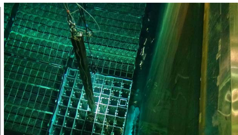
共用プールへの使用済燃料(変形燃料)の格納 (平成26年11月4日撮影)
