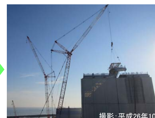
屋根パネルの取り外し 撮影：平成26年10月
