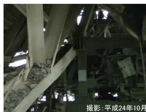
建屋カバー内の状況 撮影：平成24年10月
