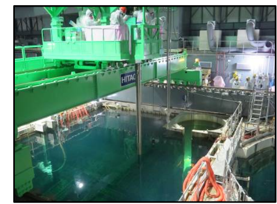
使用済燃料プールからの燃料取り出し
