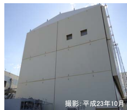
建屋カバーの設置状況 撮影：平成23年10月
