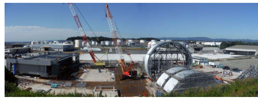
建屋カバーの製作状況（小名浜）
