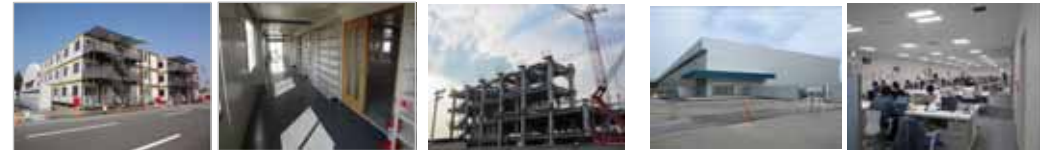
仮設休憩所と建設中の大型休憩所
