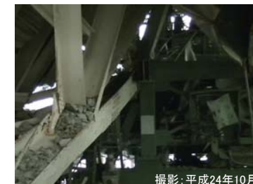
建屋カバー内の状況
