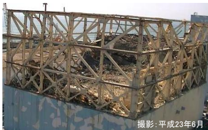
建屋カバー設置前の状況
