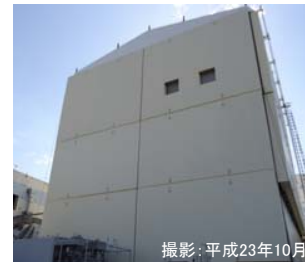
建屋カバーの設置状況
