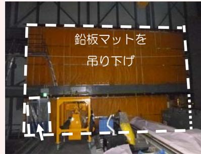
① 3号機側からの放射線を防ぐために、3号機側壁沿いに鉛板マットを設置
