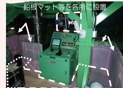
② 燃料取扱い機上の操作盤まわりを、遮へい材で囲い、操作する作業員の被ばくを低減
