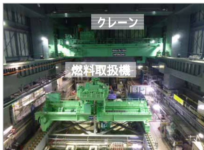
燃料取り出し用カバー内部
