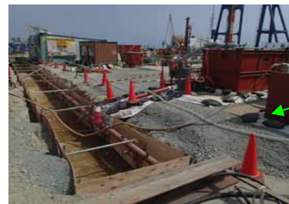
ウェルポイント(くみ上げ井戸)の敷設状況
