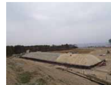
2槽目の状況 (3/25撮影)
