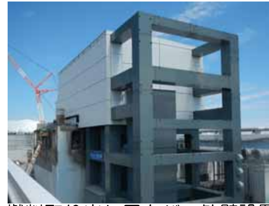
燃料取り出し用カバー外壁設置
