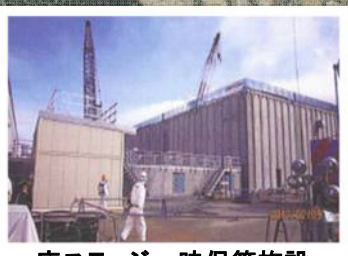
廃スラッジ一時保管施設
