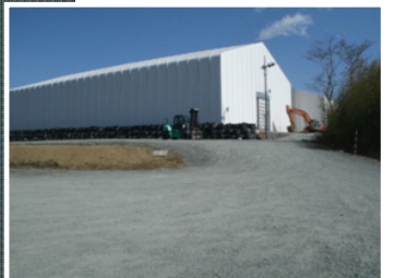
瓦礫保管テント
