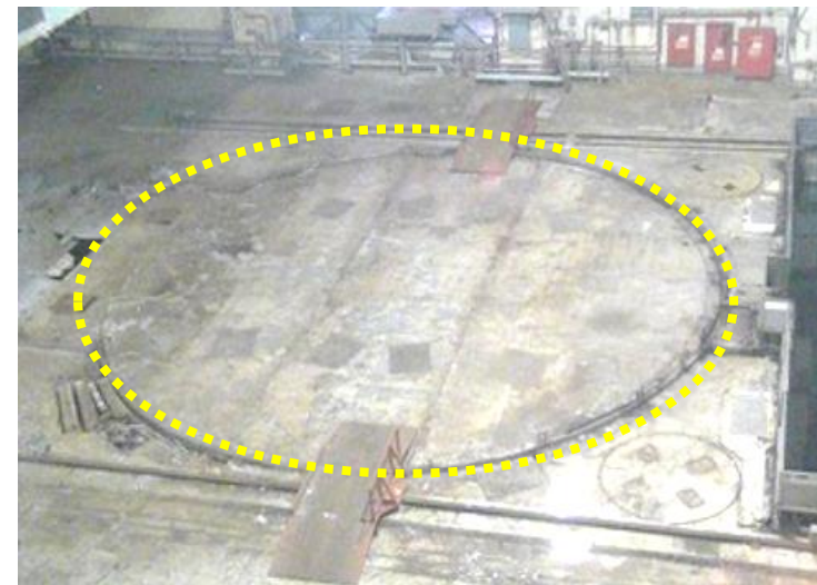
2号機 原子炉ウェル上部
