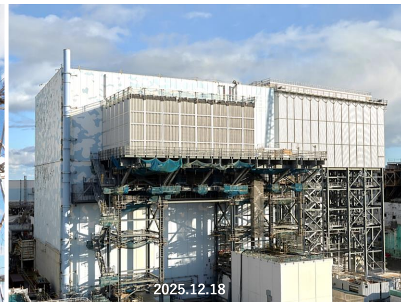
使用済燃料取り出し構台 設置
