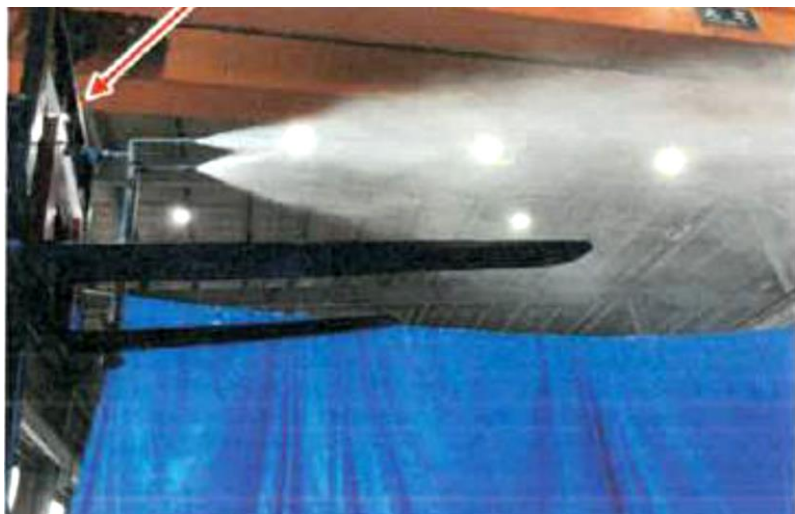
散水設備 噴霧状況
