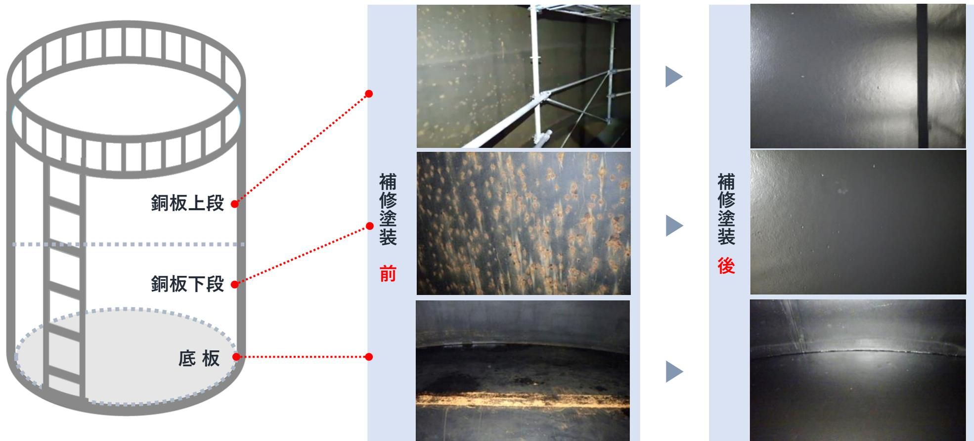
全10基のうち1基で胴板の減肉、別のタンク2基でマンホール部の腐食を確認したため、溶接補修等を実施しました。
