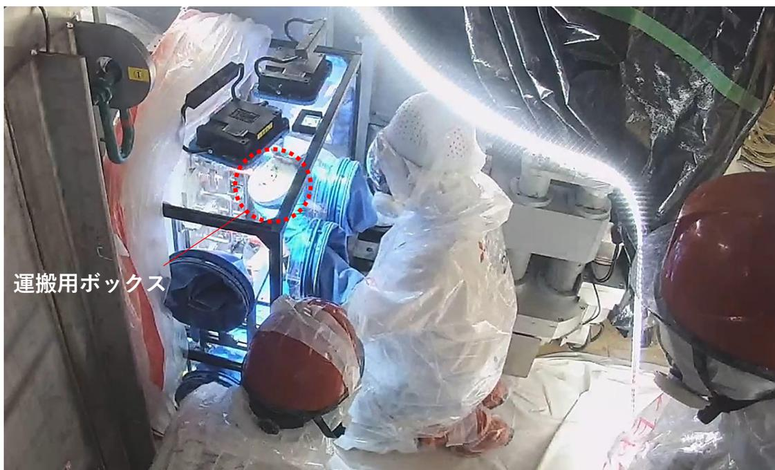
「運搬用ボックス」を「建屋内運搬容器」へ収納する様子
