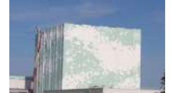
燃料取り出し実施中 2025年度上期 完了予定
