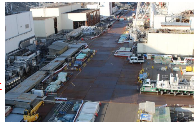
2/3号機間道路周辺フェーシング工事
