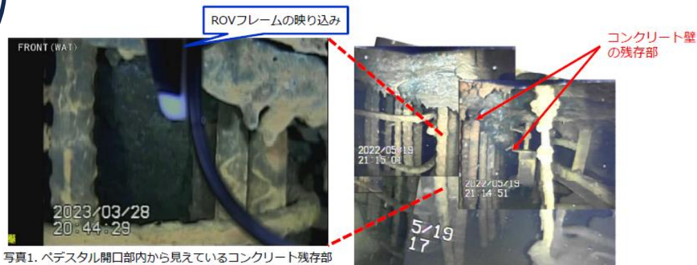
写真2. ペDESTAL外部から見えているコンクリート残存部
