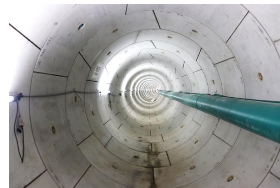
放水トンネル内
