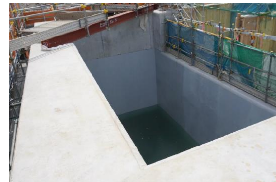
放水立坑（下流水槽）
