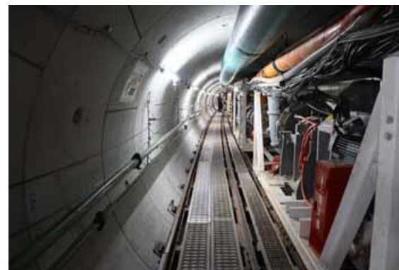
トンネル掘進完了後の放水トンネルの様子
