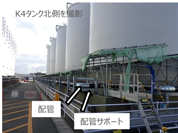
循環配管・サポート設置の状況
