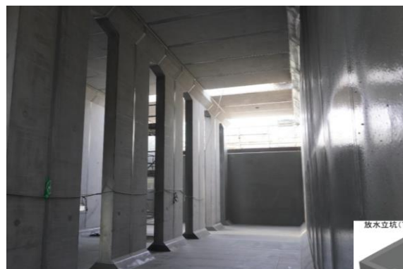
上流水層内部の状況 (防水塗装完了)
