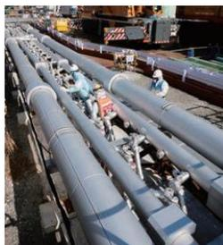
土を凍らせて地下水を遮水する陸側遮水壁は2016年3月より凍結を開始。2018年3月にほぼ全ての範囲で地中温度が0℃を下回り、効果が発揮されていると評価を受ける。
