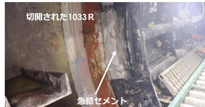
トンネル先端状況(止水工事の状況)
