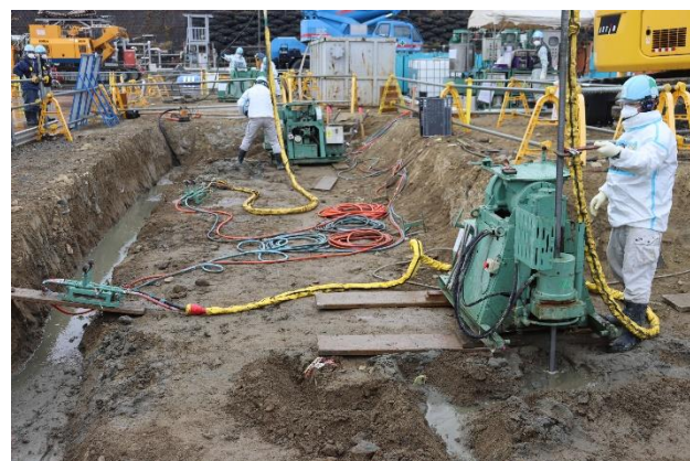
地盤改良の状況
