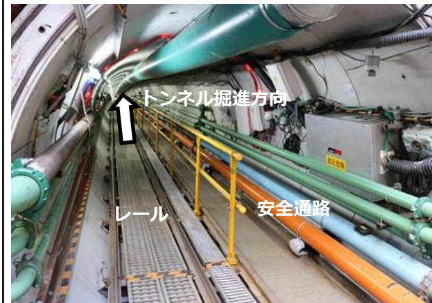
トンネル内部安全設備の整備状況
