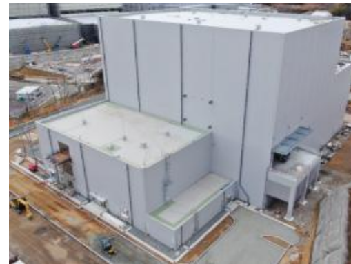
増設雑固体廃棄物 焼却設備建屋全景
