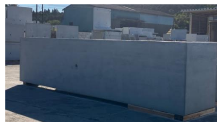
上流水槽側壁
