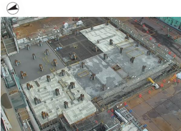
2号機原子炉建屋南側ヤード全景(2022年11月21日)
