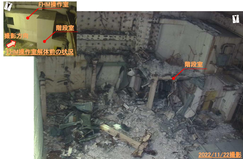
解体中の現場状況写真
