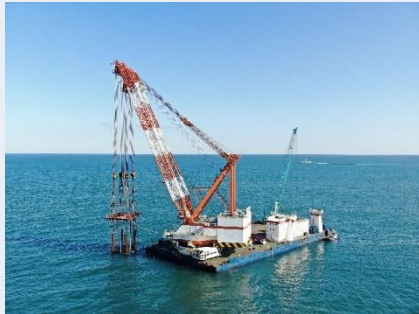
放水口ケーソンの据付工事の様子
