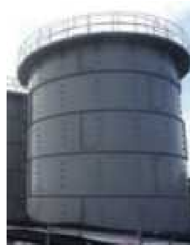
フランジ型タンク
