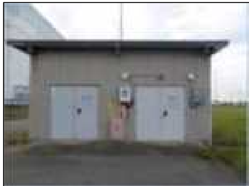
ポンベ建屋 (例)
