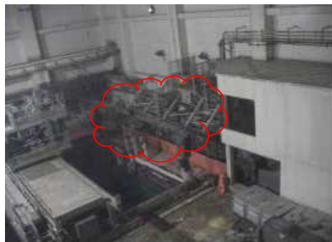
干渉物撤去 (使用済燃料プール南側既設設備撤去)
