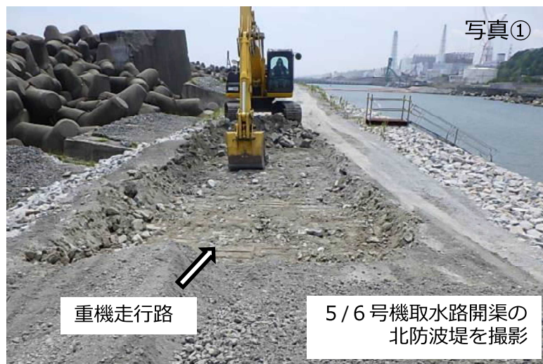
重機走行路整備の状況
