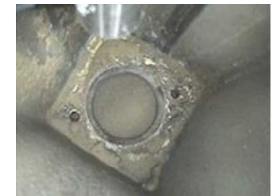
使用済燃料プール内水中カメラ調査状況 燃料ラック底部
