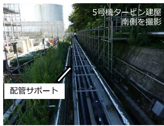
移送配管サポート設置の状況
