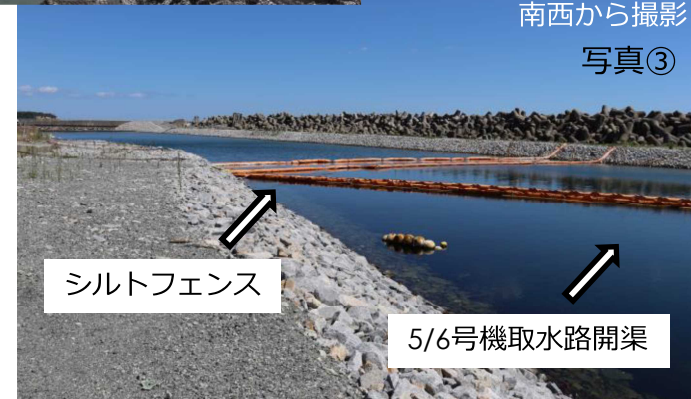
5・6号機海側工事エリアの状況
