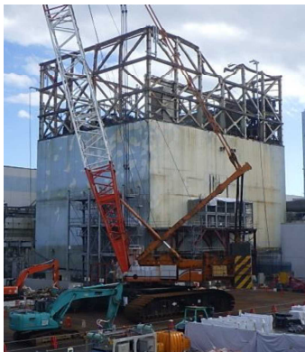
1号機原子炉建屋現場状況
