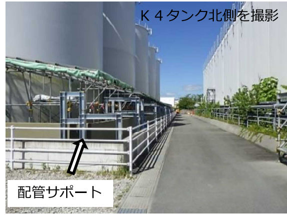
循環配管サポート設置の状況
