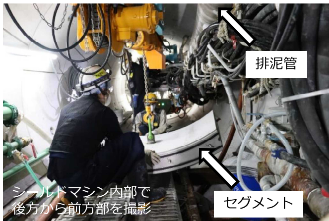
セグメント搬送状況（トンネル内）
