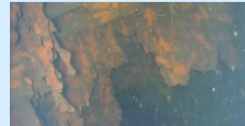
ペDESTAL内側の状況
