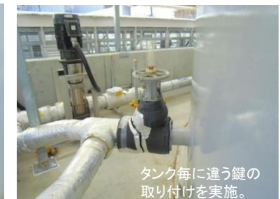
J3雨水回収タンク払出弁
