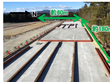
構外ヤード状況(2022年1月19日)
