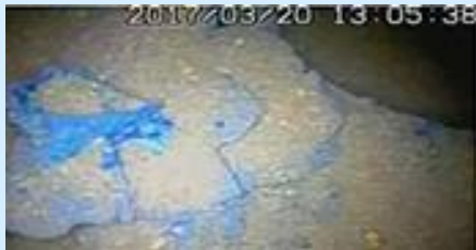
ペDESTAL外側の状況
