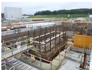
基礎工事(2021/8/20撮影)
