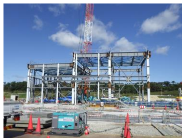
鉄骨工事(2021/10/20撮影)
